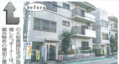
4 苦しかった築30年印刷エントランス
