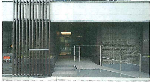
▶外観にルーバーを加え、居・オフィス両方に合った物件を築いた
