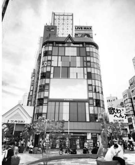
▶大きなデジタルサイネージが目を引き、リモデル後の「三宮OSビル」ビル名のロゴデザイン
